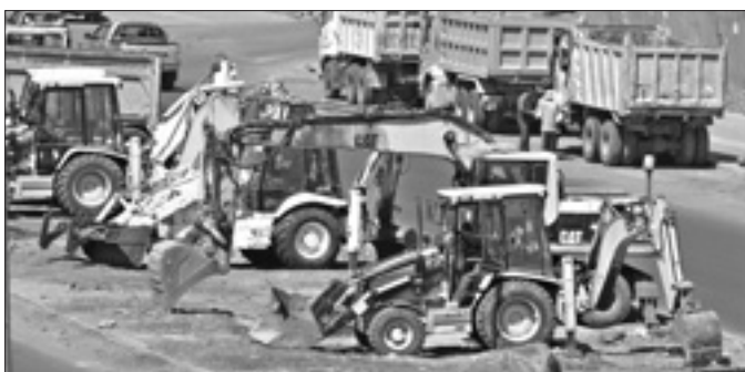
Lavori in corso ad Addis Abeba
