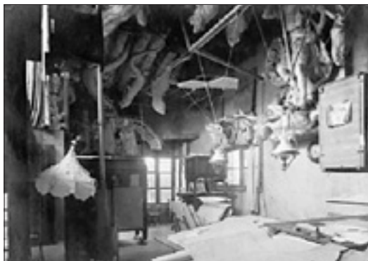
Lo studio di Gaudí a Barcellona durante i lavori per la Sagrada Família
