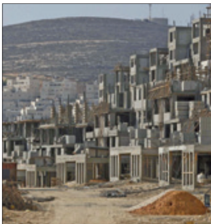
Un insediamento israeliano in via di costruzione in Cisgiordania (Reuters)
