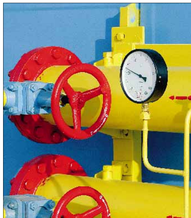
Il nuovo compressore di gas installato nel villaggio di Mryn
