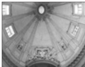
L'interno della cupola prima del restauro
