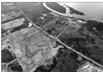
Una visione aerea del sito dei lavori per la centrale di Belo Monte (Afp)
