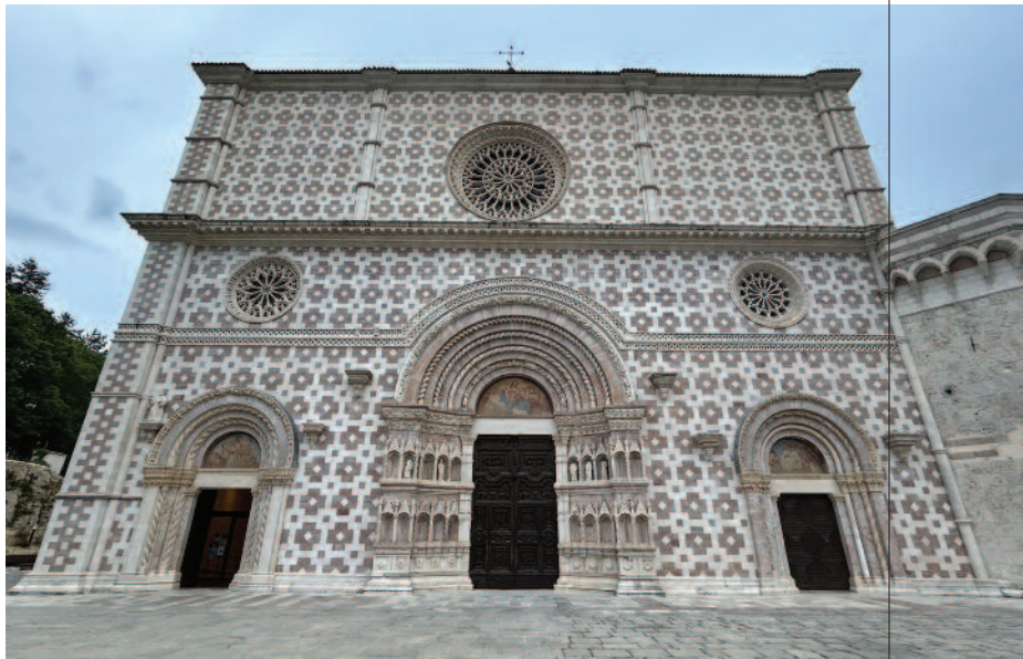
Le Pape Célestin V, qui inspira la proclamation du premier jubilé en 1300, repose dans la basilique Sainte-Marie de Collemaggio à L'Aquila, dans la province des Abruzzes en Italie.
